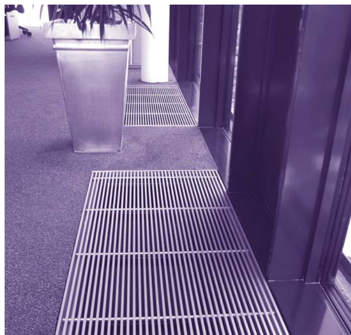
Напольный эжекционный доводчик TROX серии BID с линейной решеткой
